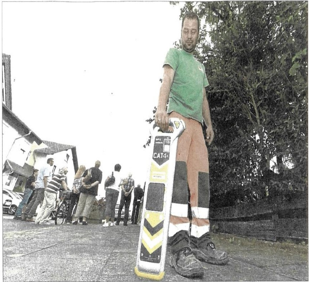
Kreuzung Kreuzburgweg/Alte Holzgasse in Niederdrees: Das Warten hat sich ausgezahlt. Die Bürger freuen sich über die Inbetriebnahme des neuen Lichtwellenkabels durch die Firma Blatzheim Networks Telecom GmbH. Techniker Dominik Kanis mit einem Ortungsgerät für erdverlegte Kabel.
